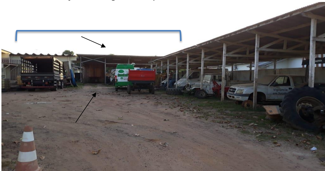
Foto 01 Área da construção da Garagem Municipal
